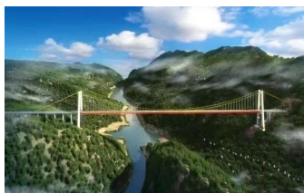
贵州桐梓河特大桥
