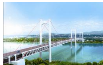
中国浙江瓯江北口大桥
