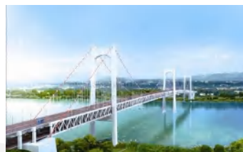
中国浙江瓯江北口大桥
