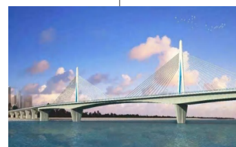
广东金海大桥
